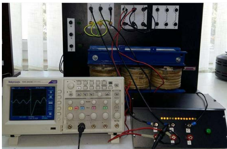
Fig. 7.6 Stand experimental pentru verificarea indicelui orar la transformatoarele electrice trifazate
